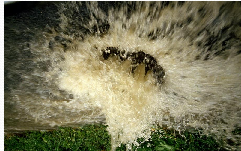
Beispielhaft: Starkregen in der Dorfstraße »springende« Kanaldeckel
